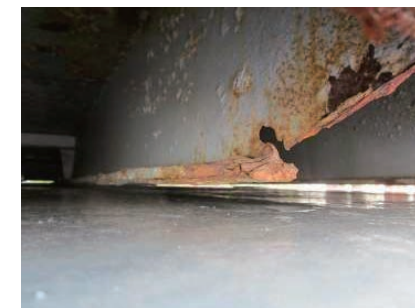
写真4 ハッチパネルの腐食
