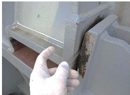
写真14 フィラーゲージで隙間を測定
