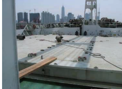
写真6 ハッチカバー上にD-ringが溶接されている
