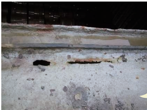
写真12 パネルのサイドプレートとコーミングテーブルが接合するタイプ。パネルとコーミングの表面に溝や腐食がある。
