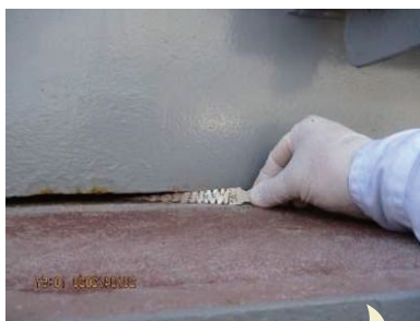
写真11 フィラージを用いてスカート部の隙間をチェックする
