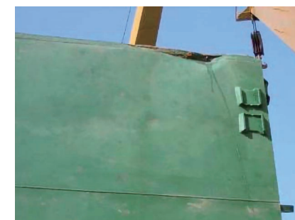
写真5 荷役作業による損傷
