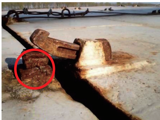
写真17 「バナナ」型のクロスウェッジ ストライクプレート
