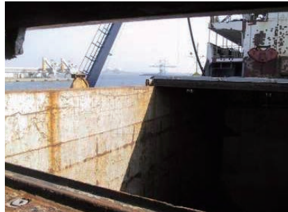
写真7 ハッチコーミングの内側に水漏れの跡
