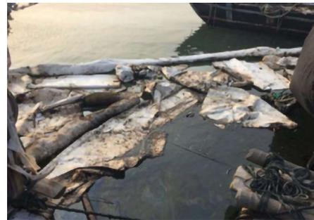
写真13 油吸着材による回収
