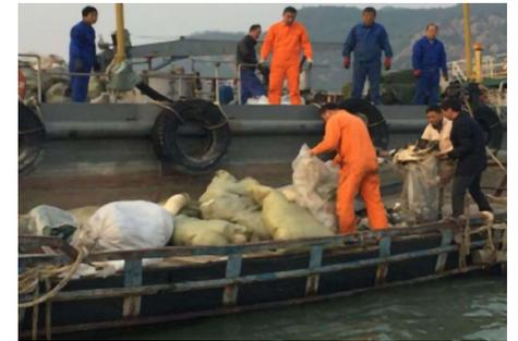
写真14 油吸着材による回収作業
