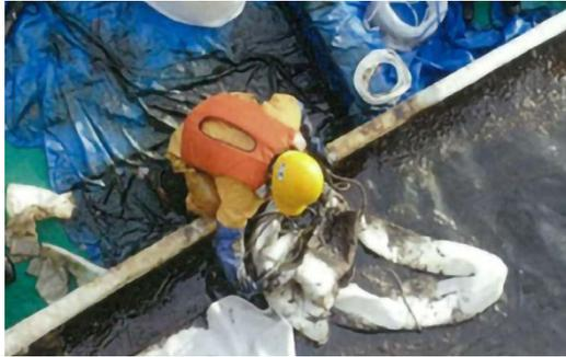
写真 24 油吸着材による回収作業
