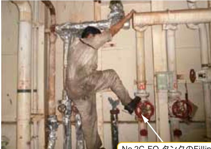
No.2C FO タンクのFilling Valve
