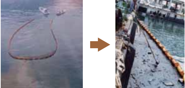
写真 8 出典：オイルフェンス展張例
