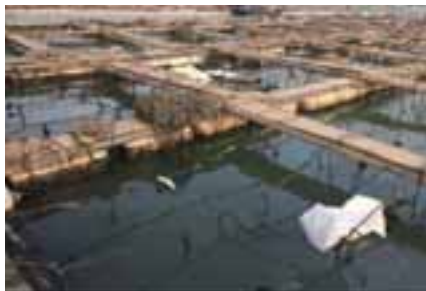
写真11 漁業施設の被害状況
