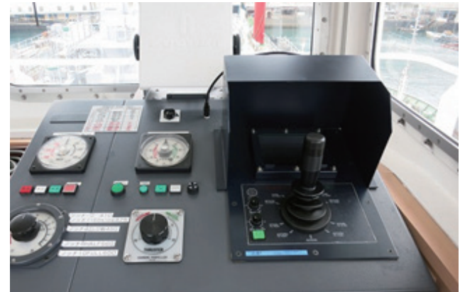
図 41 遠隔操縦装置
