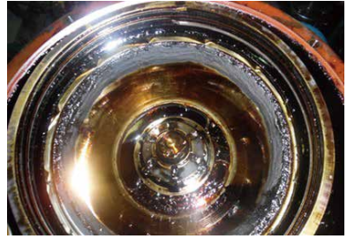
C重油清浄機：重質&硬いスラッジで閉塞。
