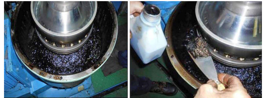
写真 5-9 油清浄機の回転体内部に堆積したスラッジ
