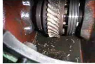
重質スラッジが原因で過負荷となり、C重油清浄機のギアを損傷。
