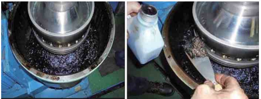
写真 5-9 油清浄機の回転体内部に堆積したスラッジ
