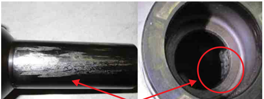
写真 5-14 燃料噴射弁での掻き傷
