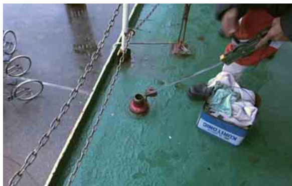
写真 4-2(a) 補油作業 タンク液位実測
