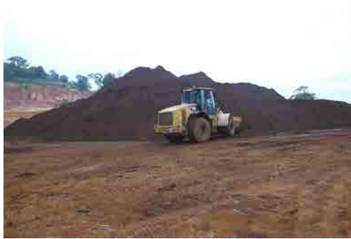
250,000 トンのストックパイル
