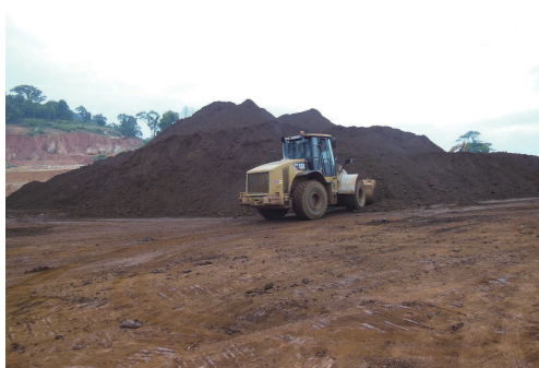
250,000 トンのストックパイル
