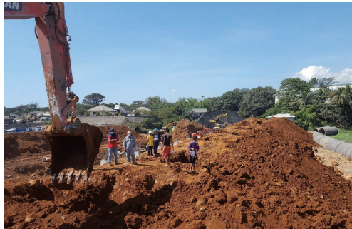
掘削機によるサンプリング
