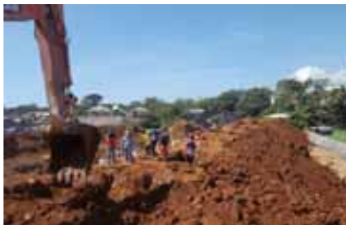
掘削機によるサンプリング
