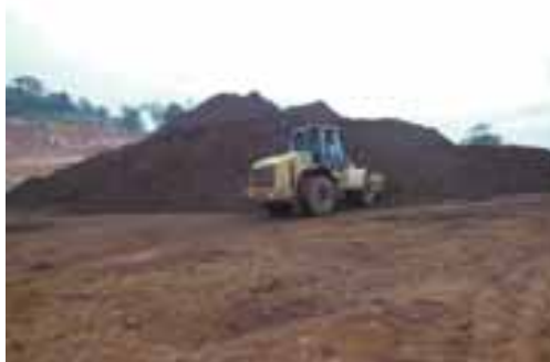
250,000 トンのストックパイル
