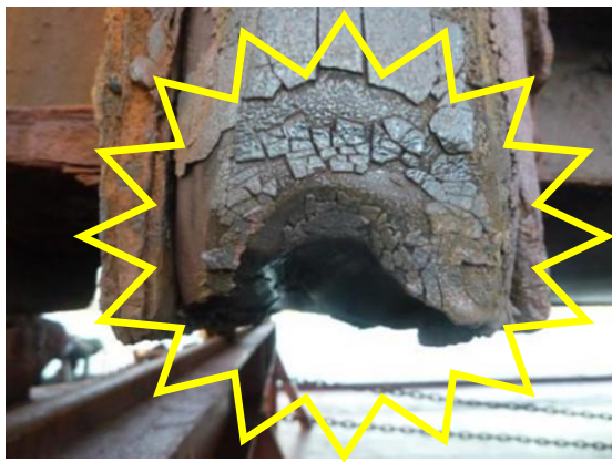
ハッチカバー用ガスケット不良 (変形/硬化)
