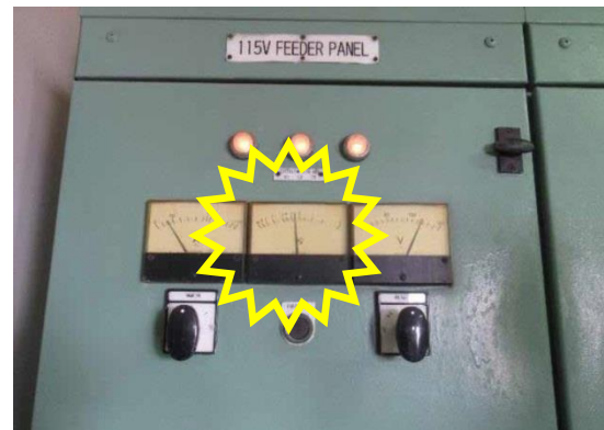
電気回路の絶縁不良
