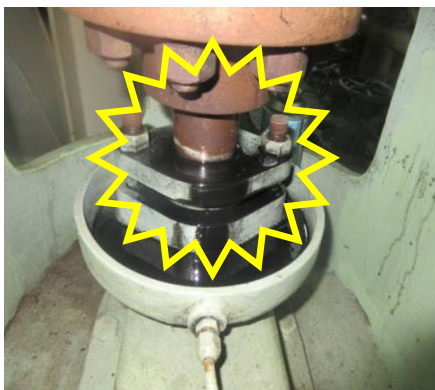
ポンプ軸封部からの漏洩
