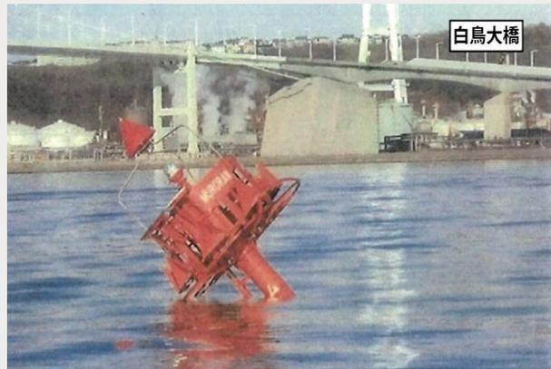
写真 67 第2号灯標の損傷状況
