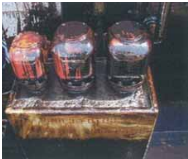
参考写真 39 No.3 燃料油タンク エアーベント (オーバーフロー後)
