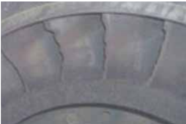
c) 破損したノズルリング 2014 年度 出力低減
