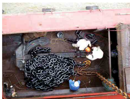
図 48 錨の接続工事
