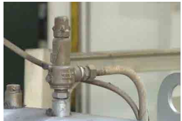
図 96 燃料油加熱器の安全弁
