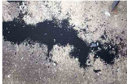
図62 工場作業通路の煤
