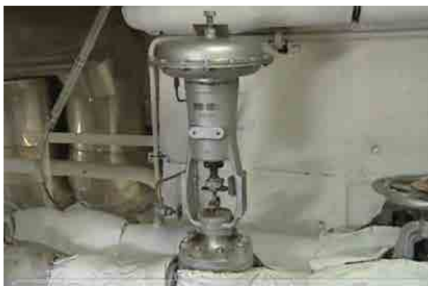
図 97 ダイヤフラム板破損
