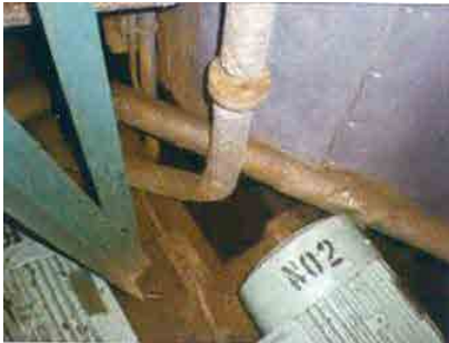
図 34 ポイラケーシング下部 (上部からの漏水痕)
