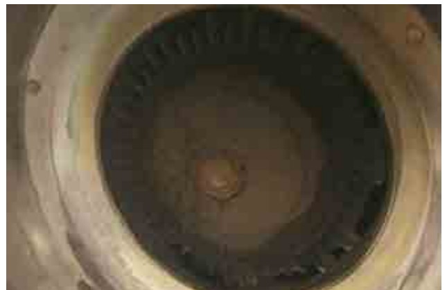
f) 破損したタービン翼 2013 年度 出力低減
