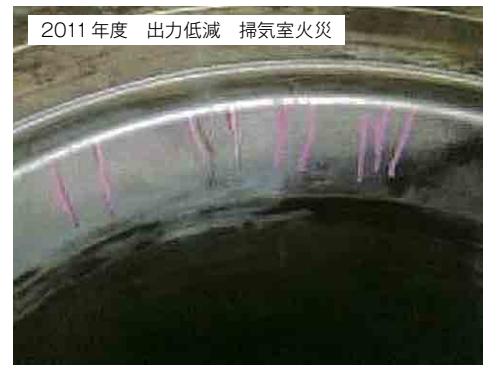
図 27 亀裂の発生したライナー 2011年度 出力低減 掃気室火災 参考文献 *10
