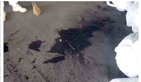
図63 工場屋内通路の煤
