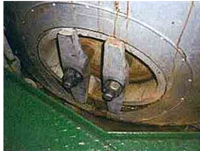
図 35 下部ドラム / マンホール (上部からの漏水痕)
