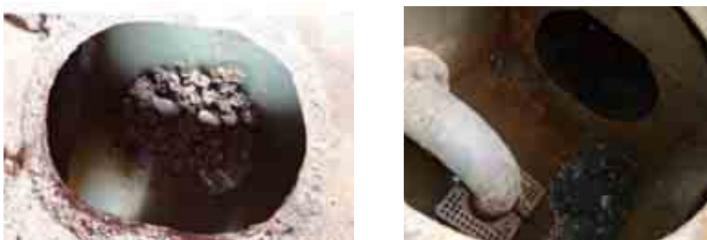
註：前航の貨物残渣がビルジウェルに残っている状態。異物によりビルジが排出出来なくなっていました。
