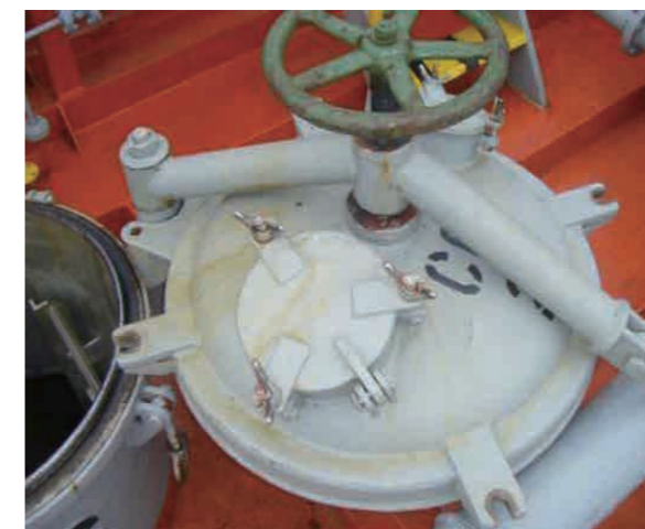
マンホールハッチ
