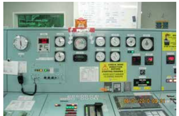
機関制御室コンソール
