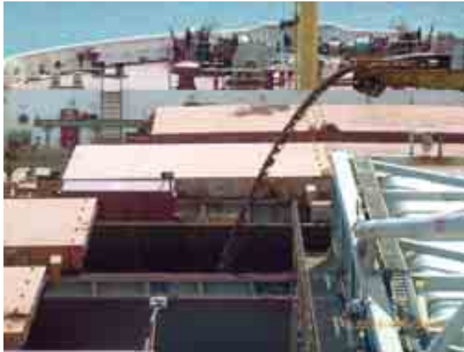
写真7 コンベヤーを使用して鉄鉱石を積載する様子 Fig.7 Loading of bulk iron ore by conveyor.
