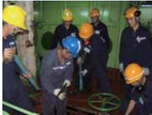
図 92 機関室内整備作業
