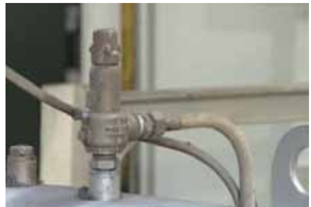
図 96 燃料油加熱器の安全弁
