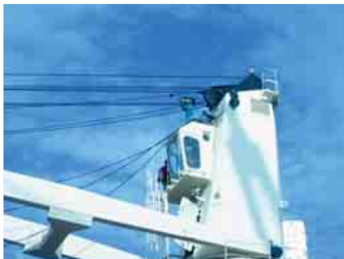
写真 2 クレーンの上部で整備を行う様子
