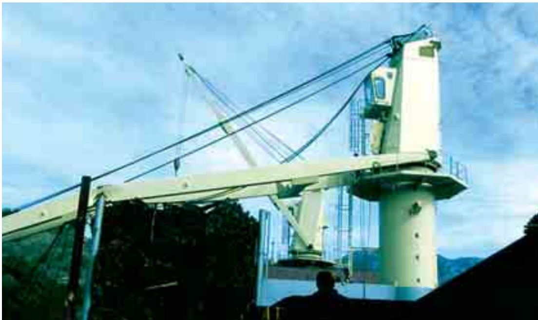
写真6 機械的な不具合により、クレーンのジブが損傷(曲損)し、多大な損害が発生した事故例
