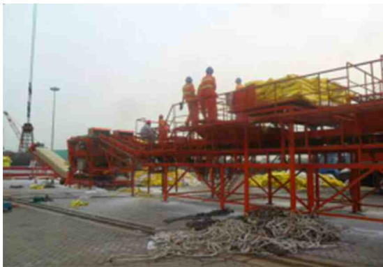
荷役作業員による陸側での開梱
