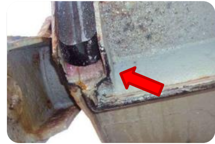
改善勧告箇所例：ガスケット欠損
